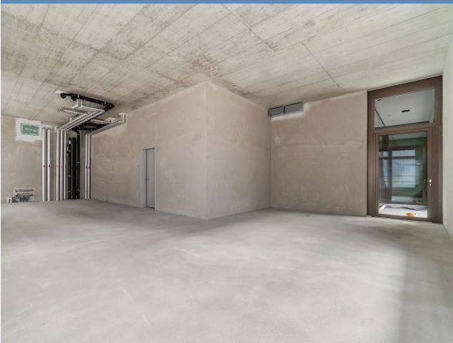
Rohbau+ (fachsprache Edelrohbau)
